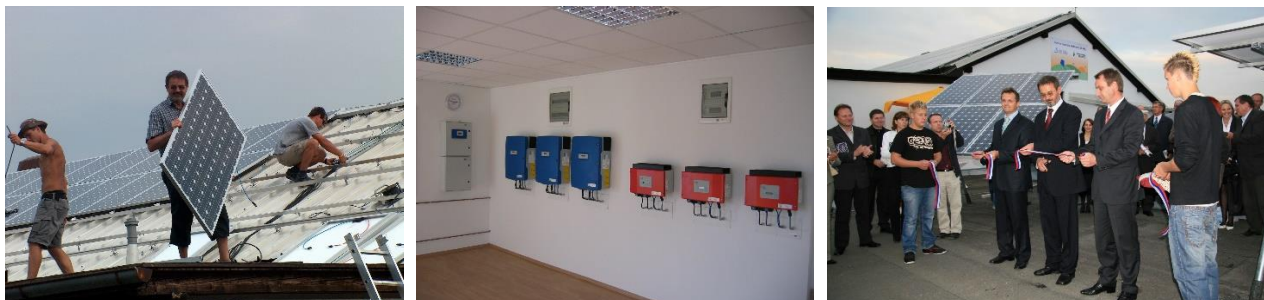
Slika 2: Montaža PV-generatorja in razsmernikov ter otvoritev sončne elektrarne SŠTS Šiška
