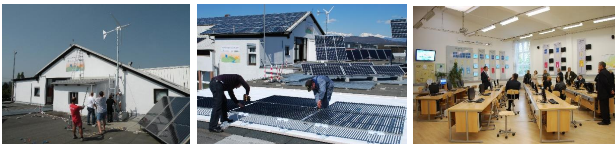
Slika 4: Spletna kamera, vetrni in toplotni generator, cevni PV-generator in nadgrajeni monitoring
